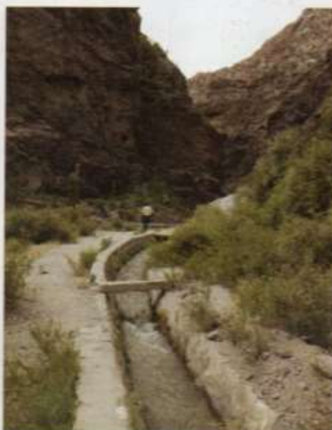
Esta acequia es un canal de agua para riego en El Remate, Los Zazos, provincia de Tucumán.
