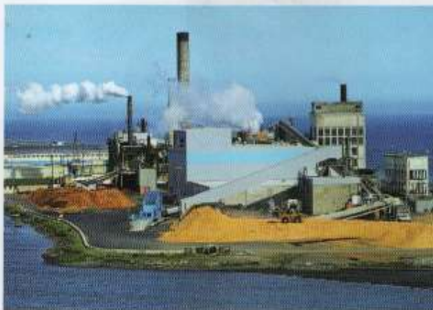
Las industrias papeleras están siempre ubicadas en las márgenes de ríos importantes.
