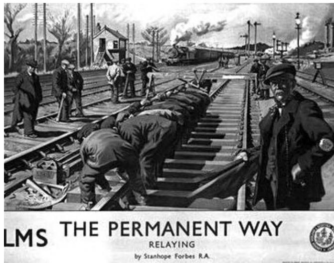
Tendido de vías en Inglaterra
