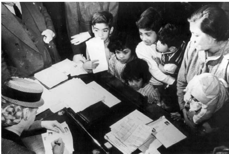
Evita trabajando en su fundación
