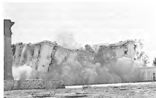
Foto 31.5. Demolición de un edificio de mampostería de dos plantas.
