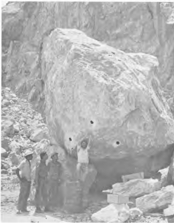
Foto 29.1. Taqueo de un gran bolo con perforación de barrenos.
