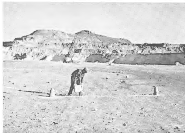
Foto 34.4. Replanteo y señalización de los puntos de emboquille en una voladura de gran diámetro.
