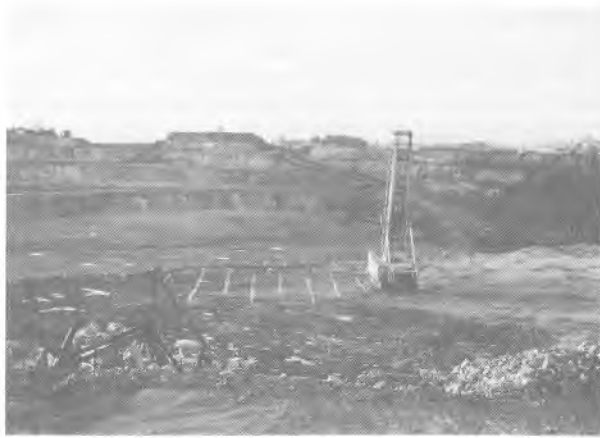
Foto 19.2. Perforación de una voladura de gran diámetro.
