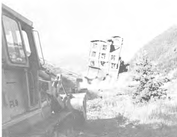
Foto 31.6. Demolición de un silo de cemento con caída en una dirección. (Cortesía de CAVOSA).
