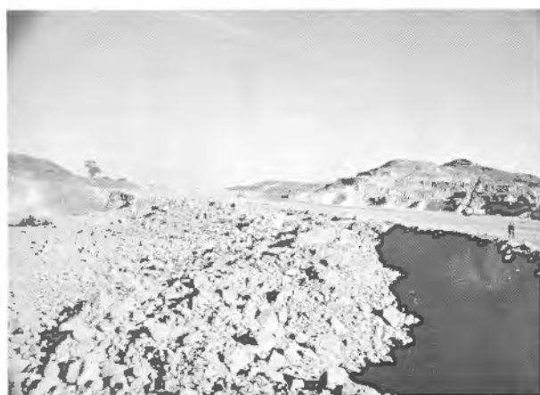
Foto 32.2. Aspecto general de una voladura en banco de gran tamaño.
