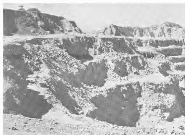
Foto 33.7. Ruinas de taludes en una explotación en la que no se realizaron voladuras de contorno.
