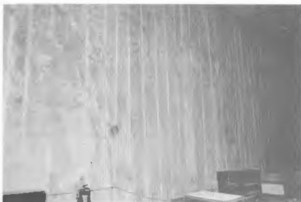
Foto 24.4. Hastiales con precorte en la Central de Saucelle (Iberduero, S.A.).
