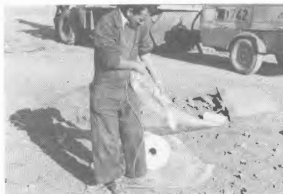
Foto 15.10. Preparación del cartucho cebo dentro de una vaina de plástico.
