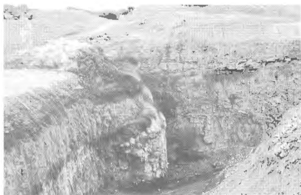
Foto 20.4. Voladura de máximo desplazamiento (Cortesía des Atlas Powder Co.).
