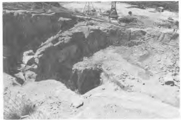
Foto 23.1. Excavación vertical de destroza aprovechando la superficie libre de una chimenea perforada por Raise Borer (Central Hidráulica de Saucelle. Chimenea de equilibrio).
