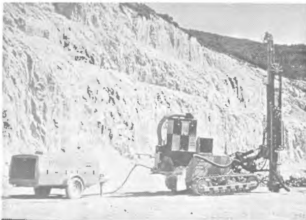
Foto 35.1. Carro perforador con captador de polvo.
