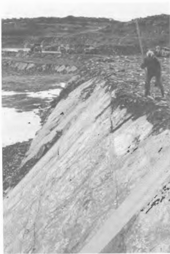
Foto 17.3. Frente de voladura coincidente con un plano de estratificación.
