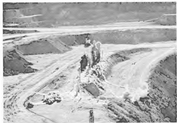
Foto 27.3. Disparo de voladura múltiple y taqueo de bolos simultáneo. (Cortesía de IRECO Canadá Inc.).
