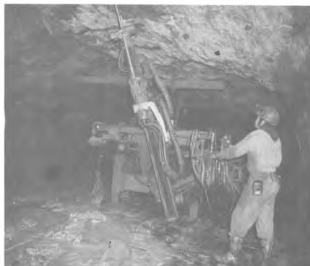
Foto 24.2. Perforación de un barreno ascendente.
