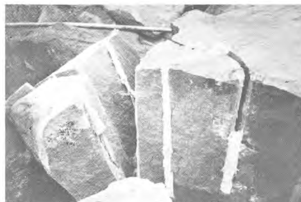
Foto 29.3. Empleo de cementos expansivos (Calmite).
