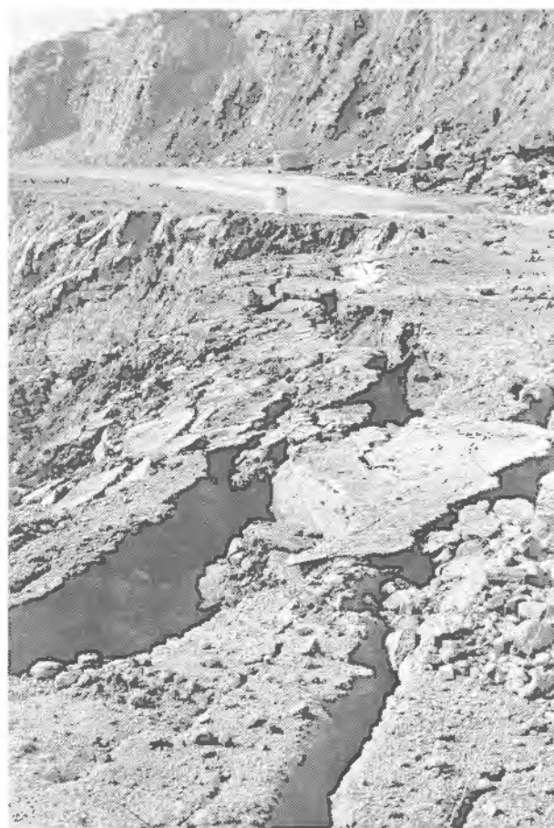
Foto 28.4. Agrietamiento y sobreexcavación producidos por una voladura en banco.
