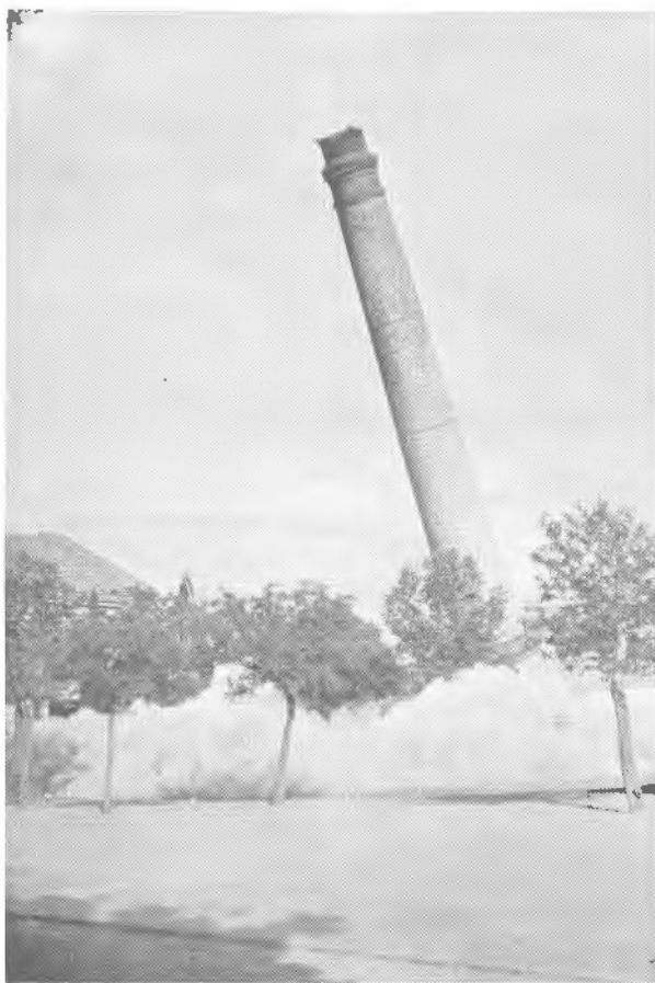
Foto 31.3. Caída de una chimenea de mampostería.
