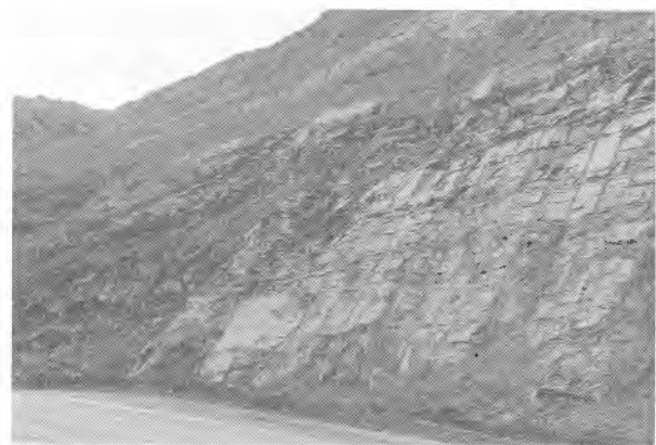
Foto 25.1. Diferencia entre talud excavado con voladura de precorte (derecha) y voladura convencional de producción (izquierda).
