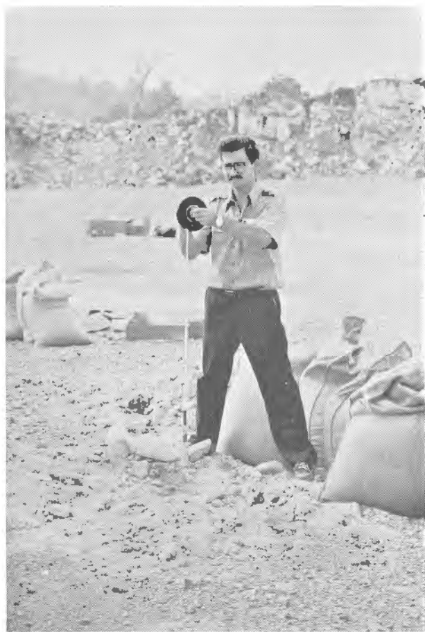
Foto 35.3. Cinta métrica flexible para control de la altura de carga y profundidad de los barrenos.
