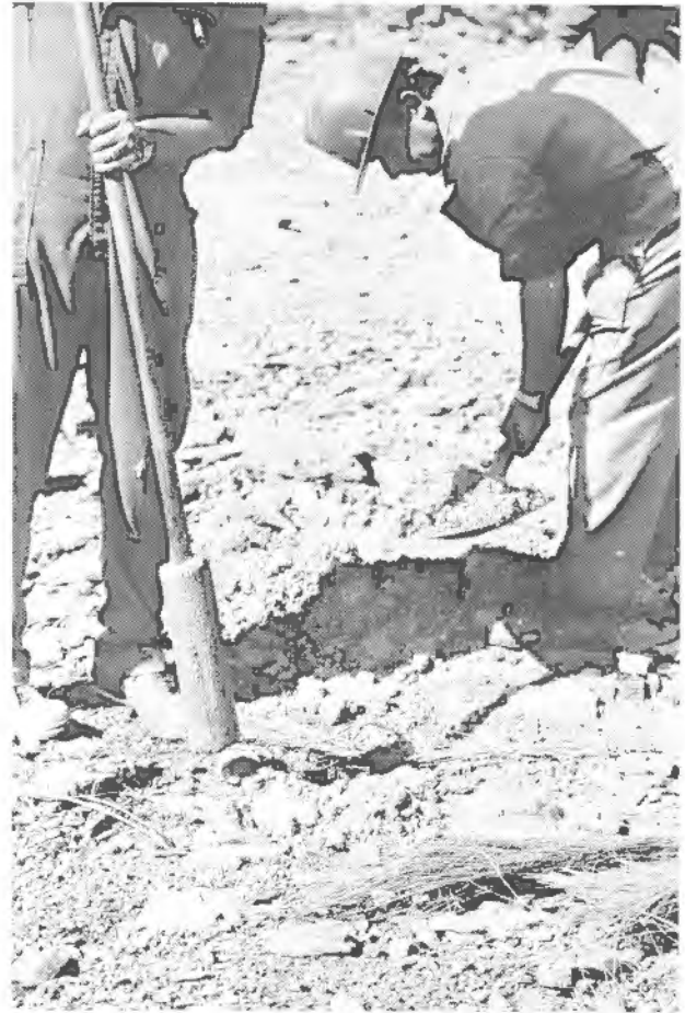
Foto 35.5. Retacado de barrenos.
