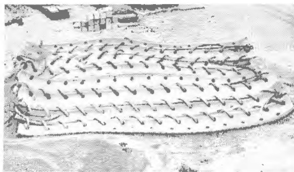
Foto 34.2. Sistema de protección con neumáticos entramados.
