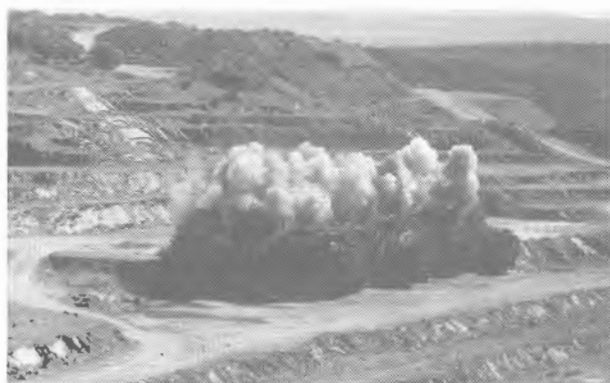
Foto 20.2. Voladura en banco multifila.
