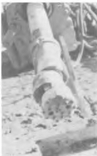
Foto 7.1. Boca de Perforación ODEX.
