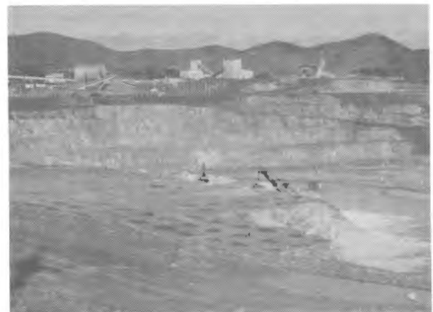
Foto 19.3. Voladura con dos frentes libres.
