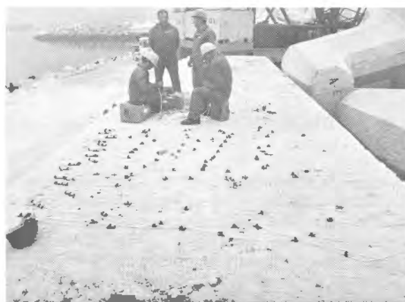
Foto 31.1. Preparación de cargas de explosivo.
