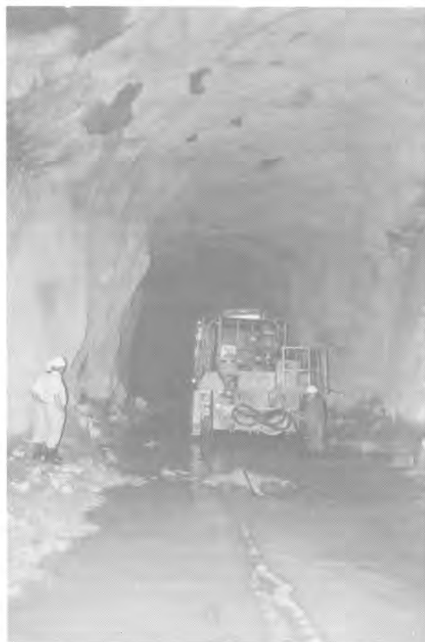
Foto 22.1. Excavación piloto y destrozas laterales de la sección superior de la galería de presión de 12 m de diámetro de la Central de Saucelle.
