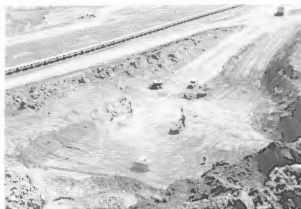
Foto 21.3. Perforación de una voladura sin frente libre vertical.
