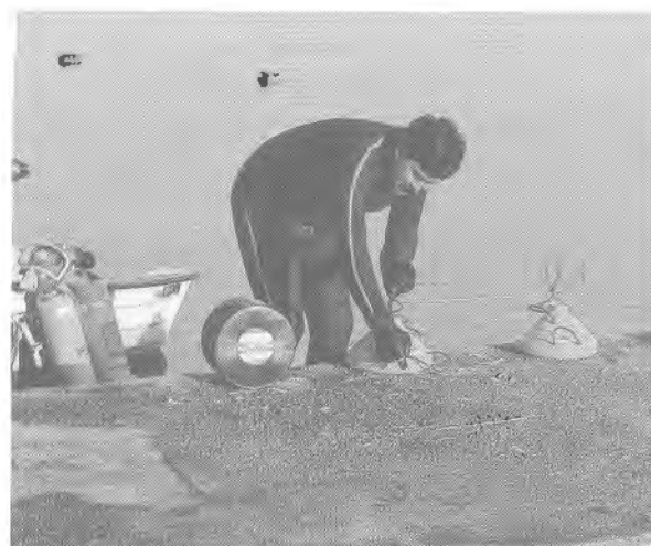
Foto 26.2. Preparación de cargas huecas para voladura subacuática (cortesía de Nitro-Nobel).
