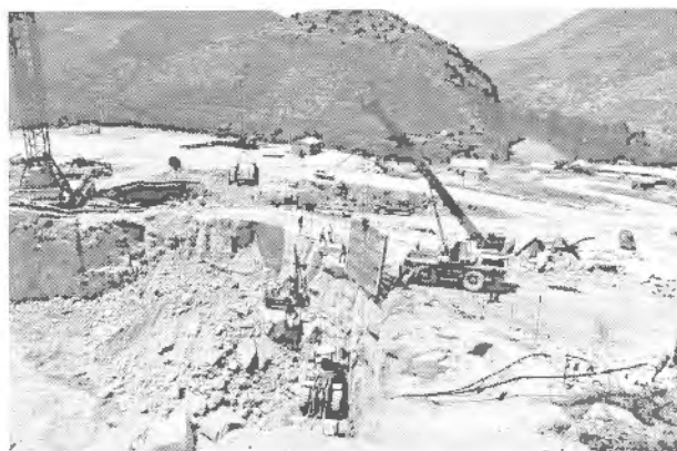
Foto 34.3. Colocación de una protección pesada sobre una pequeña voladura.
