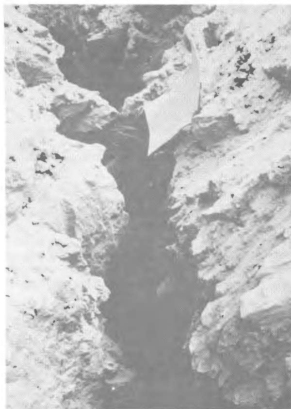
Foto 25.4. Aspecto del plano de fisuración en superficie creado con una voladura de precorte.
