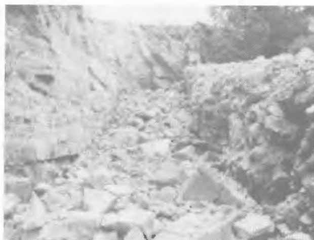
Foto 21.1. Voladura en zanja.
