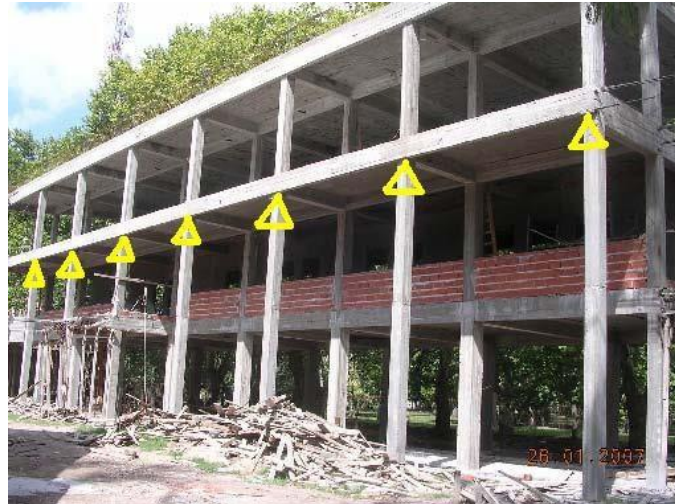
Fig. 5.4.1.: Caso real de viga continua.
