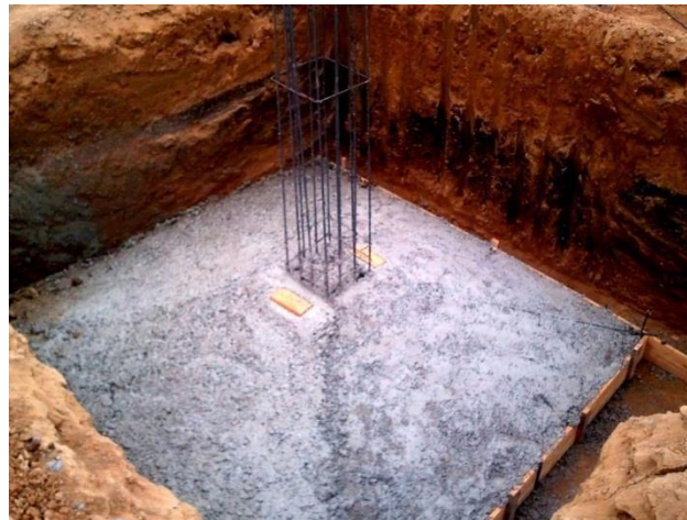
Fig. 8.4.: Base hormigonada.
