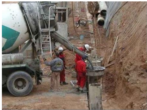
Fig. 8.1.16: Llenado de pilotes de hormigón. Fuente: http://ingecivilcusco.blogspot.com.ar/
