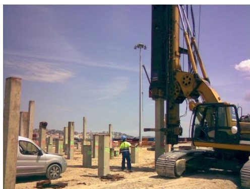
Fig. 8.1.11: Pilotes hincados por percusión.
