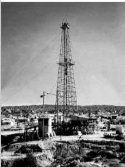
Mendoza. Torre de explotación de YPF.
