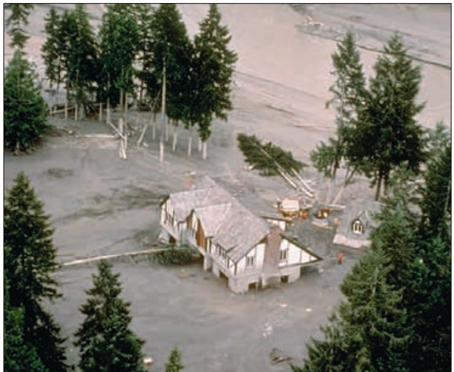
► Figura 15.7 Casa dañada por un lahar a lo largo del río Toutle, al oeste-noroeste del monte Santa Elena. La sección final de la casa fue desgajada e incrustada contra los árboles. (Foto de D. R. Crandell, U. S. Geological Survey.)
