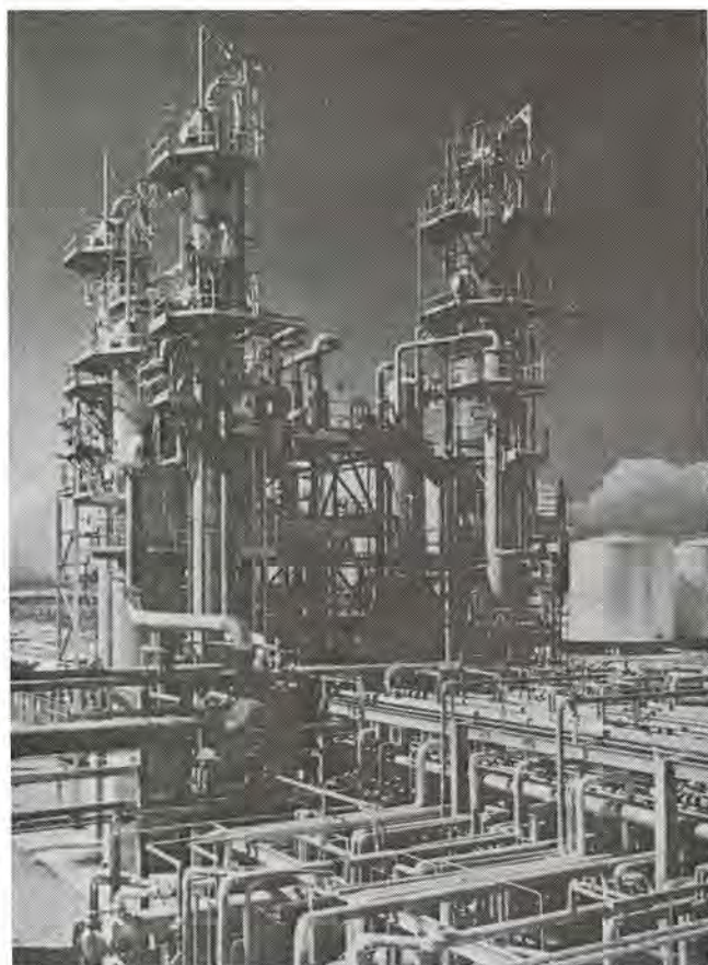
Fig. 2-1 Procesos de separación en una refinería de petróleo. El furfural, un líquido orgánico hecho a partir de la cascarrilla de avena, disuelve selectivamente los componentes indeseables del aceite lubricante. En el proceso ilustrado, el aceite lubricante fluye a través del gran ducto (lado izquierdo de la fotografía) que entra a la columna de extracción, la cual se encuentra entre las dos columnas de destilación más altas, en la parte central izquierda. El furfural se alimenta por la parte superior de la columna y sale por el fondo con los componentes indeseables. El aceite lubricante así purificado sale por el domo. El resto de las columnas que se presentan en la fotografía se utilizan para destilación y agotamiento, para recuperar el furfural y para la purificación posterior del producto —el aceite lubricante deseado—. (Cortesía de Foster Wheeler Energy Corp.)
