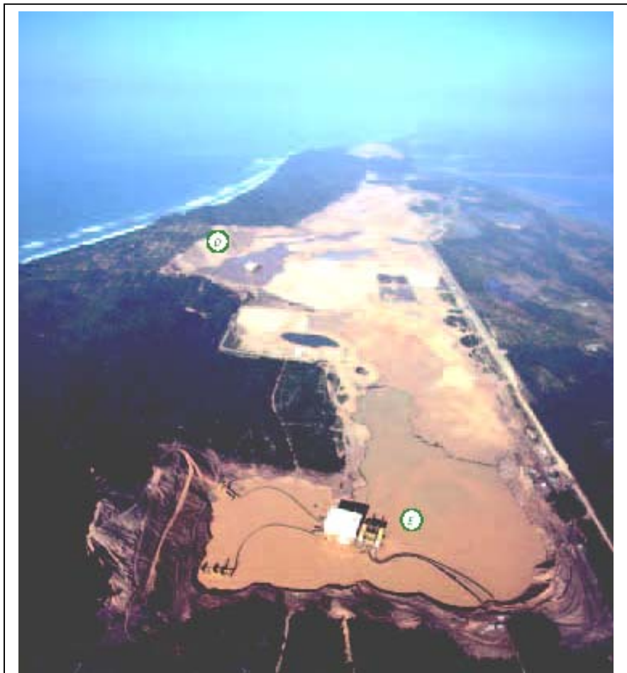
Vista aérea de la mina de Richards Bay Mineral (Grupo Rio Tinto) en la que se ven las dos balsas (posiciones D y E) en las que se encuentran sendas plantas flotantes abastecidas cada una por varias dragas. (Cortesía IHC Systems N.V.)
