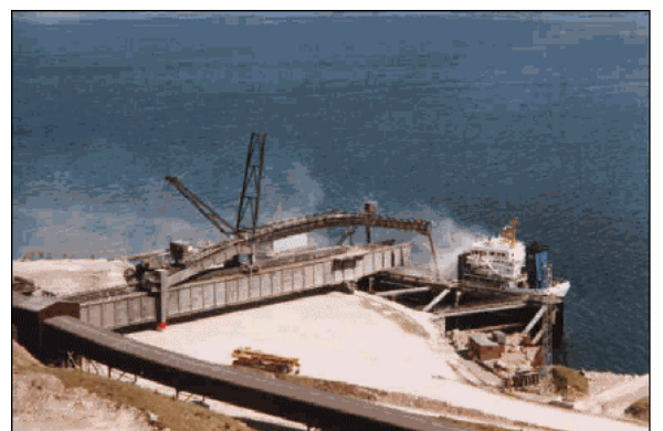
Vista de los muelles de embarque de los áridos para su transporte a los puertos de destino.
