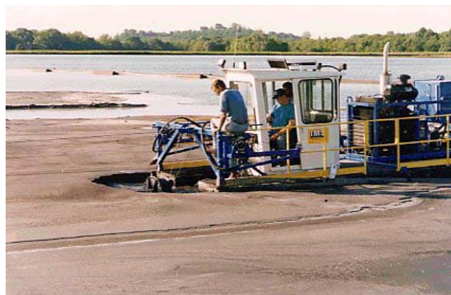
Trabajo en una presa de estériles (Cortesía IMS)
