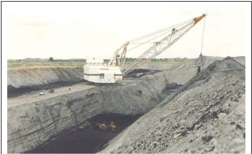
Explotación de carbón por el método de descubierta, con dragalina sobre zancas
