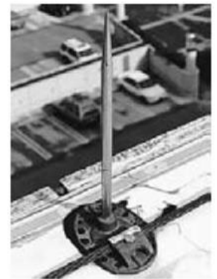
El pararrayos está conectado con alambre de uso rudo, para que pueda conducir una corriente muy grande al suelo, cuando atrae un rayo o relámpago.
