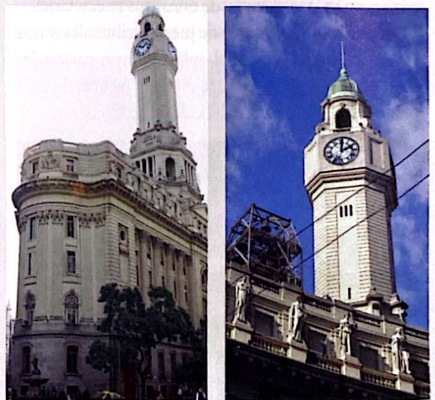
Doc. 8 Vista del Palacio de la Legislatura y detalle de la torre con reloj.
