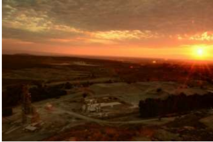
Figura 2: Fotografía aérea de la planta principal.
