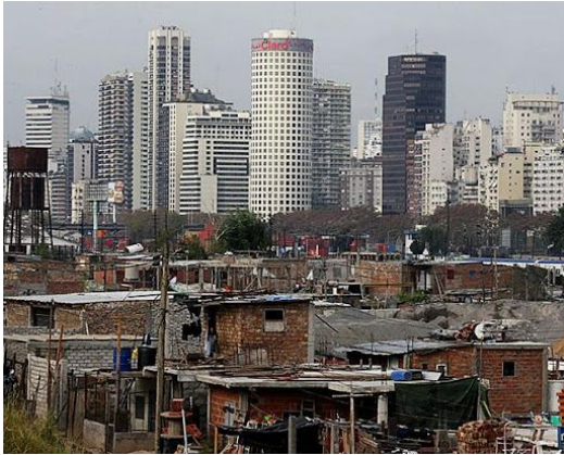
La Villa 31 y Puerto Madero
