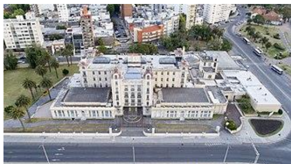
El Edificio Mercosur, la sede del bloque, en Montevideo.
