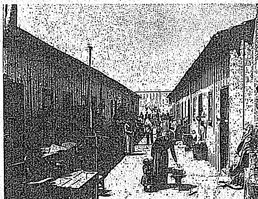
➤ Conventillo de Buenos Aires, 1900. Muchos de los inmigrantes y trabajadores se alojaron en conventillos debido a las dificultades para conseguir una vivienda.
