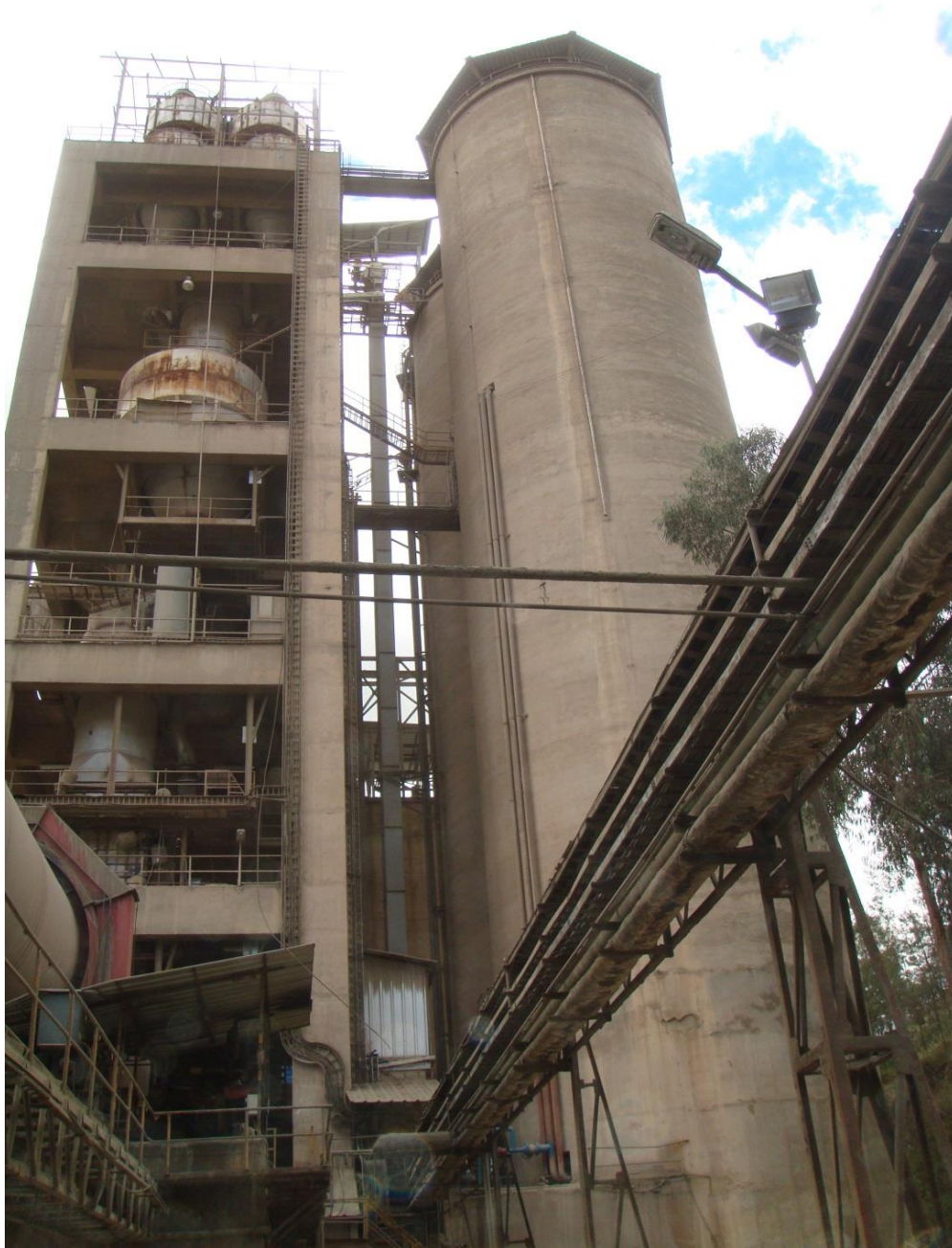
Figura 2.4. Imagen de los Silos de Homogenización y Almacenamiento de crudo Fuente: Propia
