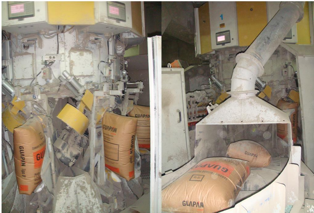
Figura 2.7. Imagen del Sistema de Empaque de cemento Fuente: Propia
