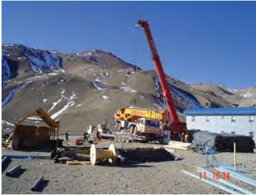
Fig.2 Equipos para izaje de cargas
