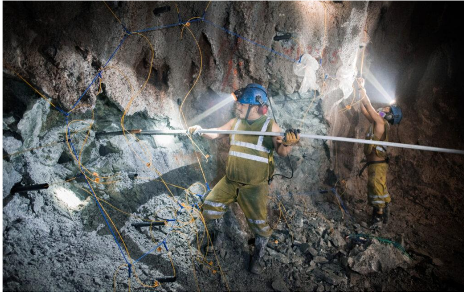
Figura 3: uso de atacador en minería subterránea.
