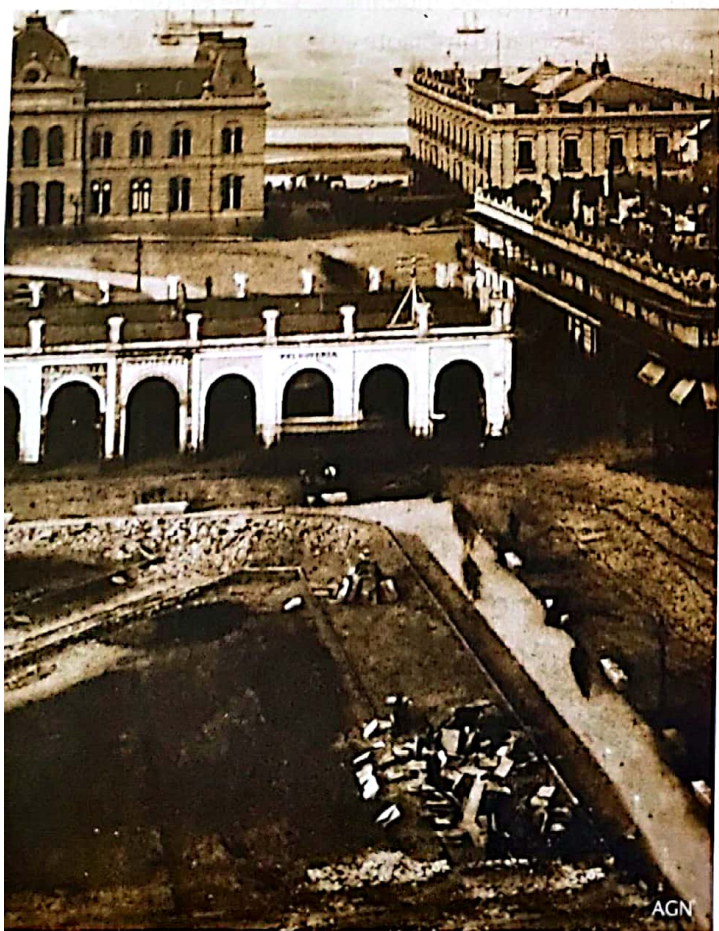
Demolición de la vieja recova en la Plaza de Mayo, 1884.
